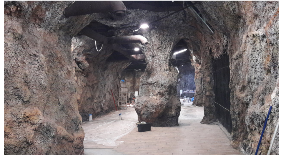
Stavba Zábavního centra ve Varšavě. Construction of Adventure Park in Warsaw.
