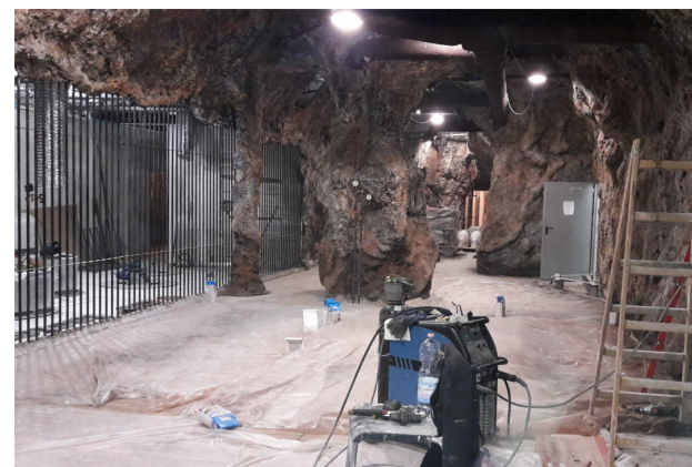
Stavba TEPfactoru Warszawa. Construction of TEPfactor Warszawa.
